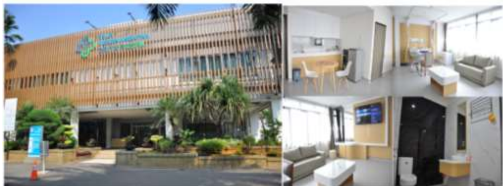
Gambar 21 Gedung Griya Puspa untuk Pelayanan Eksekutif
